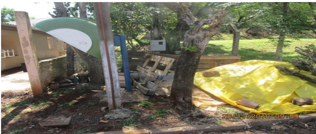
Figura 25 - Árvore em conflito com os equipamentos públicos
